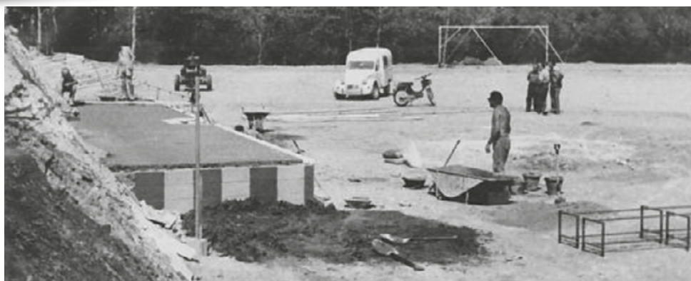
Fotos construcció camp futbol any 1975 Arxiu Benet Valentí
