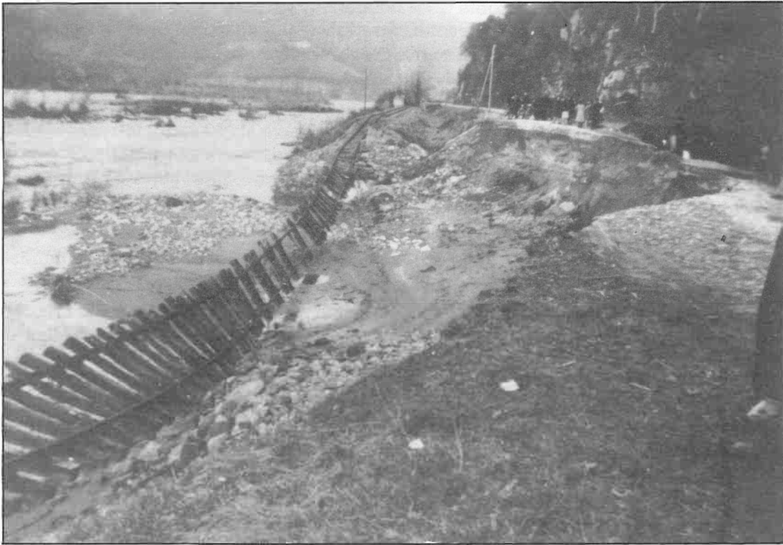
L'any 1942, les aigües del Ter, tornen a fer de les seves. En són testimoni els desperfectes ocasionats a la via del tren d'Olot en el seu pas per Vilanna.
