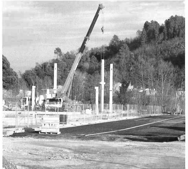
Construcció de la fàbrica SONOCO BARCELONA,SA.
