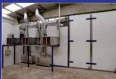
TÚNEL DE PINTURA FINS A 18 m
