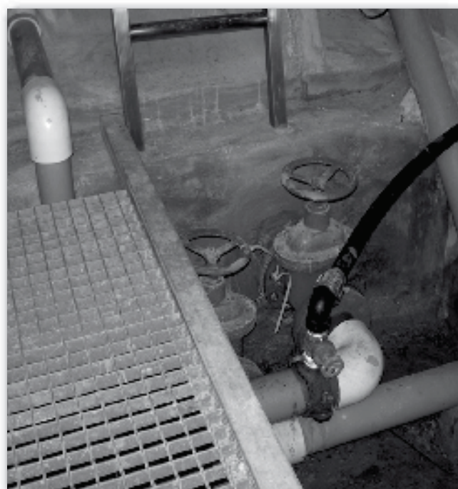
Interior de la caseta de dipòsits de Sant Julià del Llor
