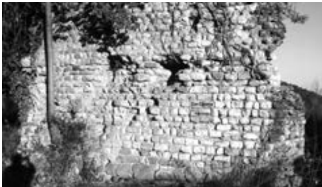
La cavorca de baix. Parament exterior.
