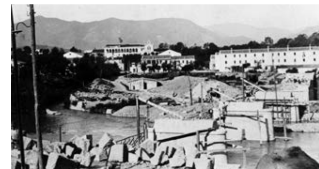
Obres de construcció del pont que ha d'unir la Colònia amb la carretera que va de Girona a Vic. Foto de 1906. Encara no s'havia aixecat la xemeneia de la paperera Torras i a la casa dels Bonmatí no s'havia construït la torre amb la punxa coronada de rajola ceràmica verda que tant la caracteritza.
