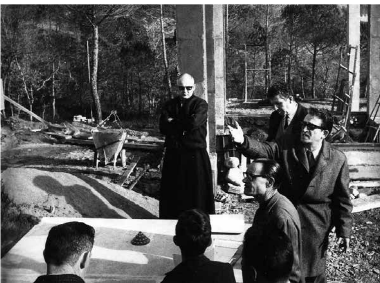
Construcció del Grup Bondia. Any 1968.
