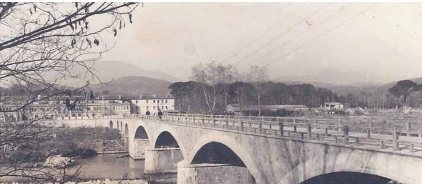
Imatge de l'any 1941 amb les arcades acabades. Encara es pot veure a l'esquerra, a dins de l'aigua, un tros del pont vell destruït durant la guerra. Font: Fons Benet Valentí / Ajuntament de Sant Julià del Llor i Bonmatí
