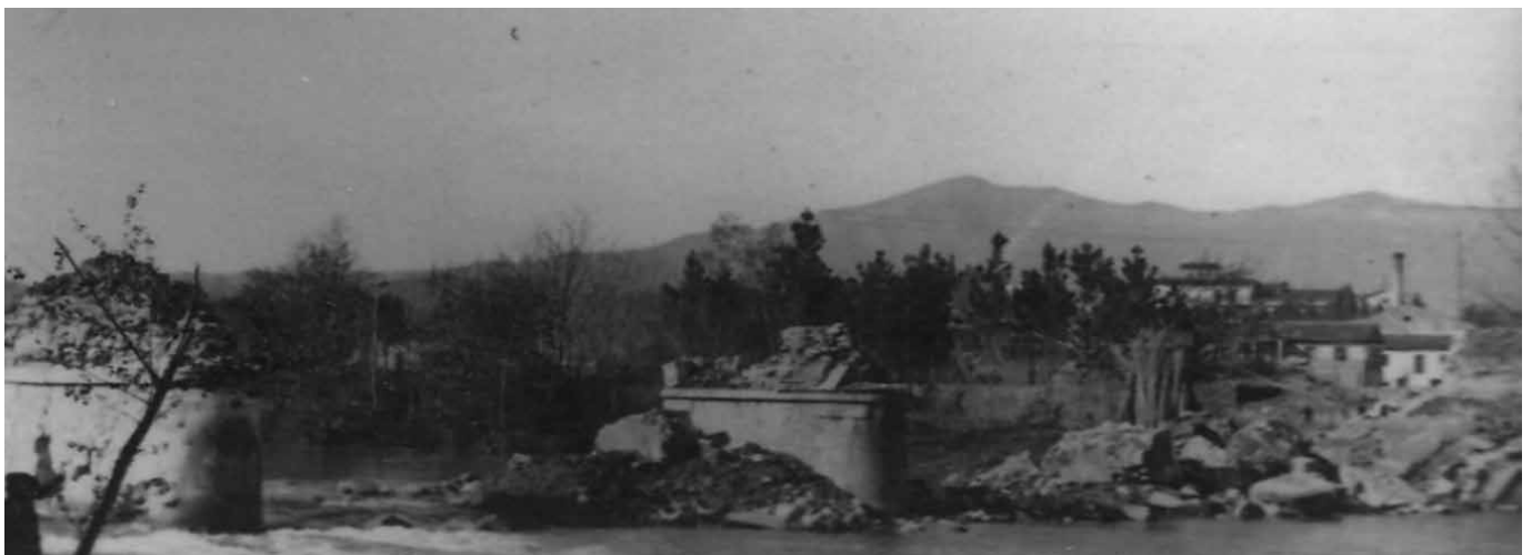
Aspecte de pont després de la seva destrucció.
